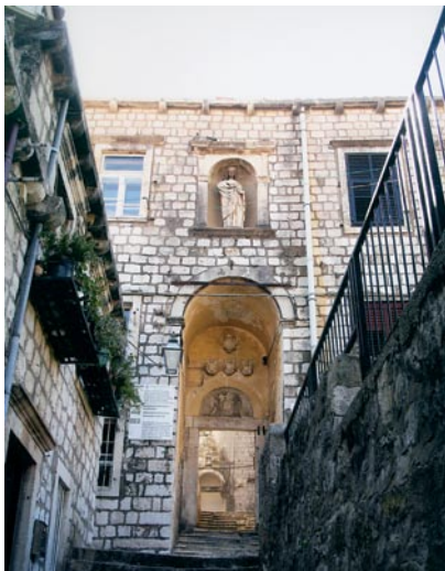
Pogled na ulaz u samostan Sv. Marije od Kaštela
