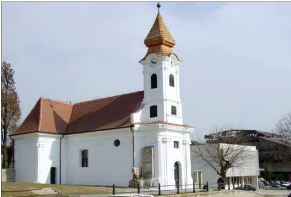
Slika 6. Kapela Sv. Roka nakon obnove
