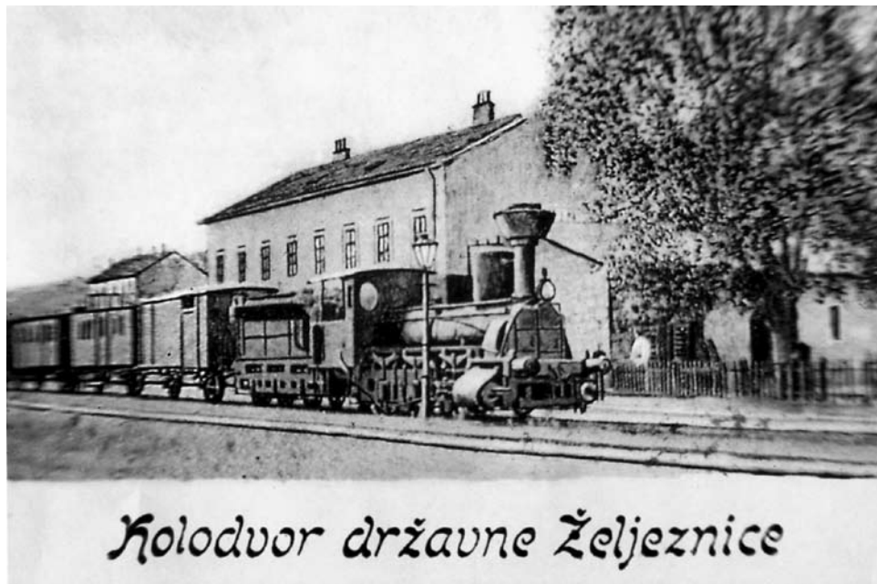
Sl. 1. Željeznički kolodvor Knin 1906. U to vrijeme bio je krajnji kolodvor željezničke pruge Split-Siverić-Knin (presnimak razglednice; fotodokumentacija HŽM-a)
