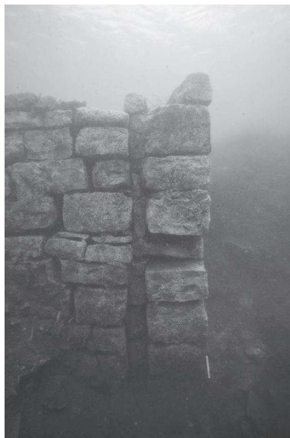
Fig. 7 : Glissière dans le mur transversal M7 (photo L. Damelet, CNRS/CCJ)
